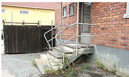
Inne på gården på gamla gatuförrådet har man fått gjort ett par extra trappsteg för att entrén skall nå ner till marken.
