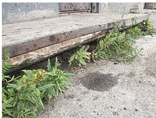
Marken har på kort tid sjunkit. Här ser vi ingången till materialförrådet.
