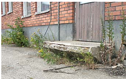
Det här är entrén in till gamla förmanskontoret.
